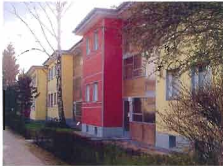
Fassade in Mariendorf nach der Instandsetzung
