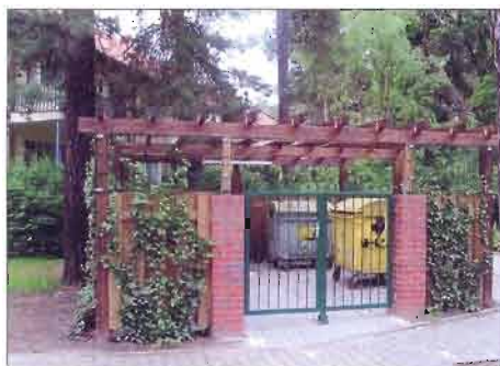
Müllstandsanlage im Ilsensteinweg
