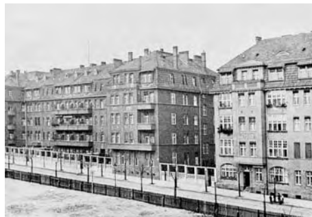
Historische Ansicht der Hausgruppe von der Reinholdstraße
