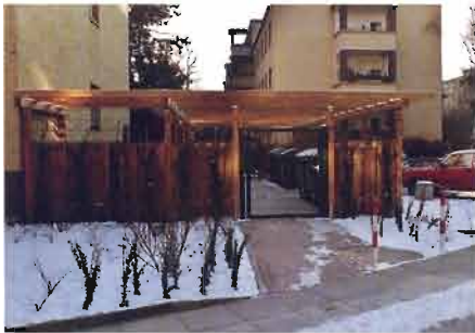
1999 fertiggestellte neue Müllstandsfläche im Langensteiner Weg (Südende)
